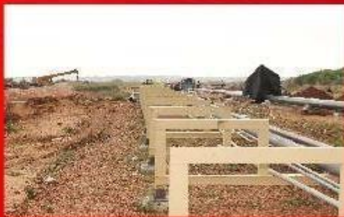
Laying of 20" LNG pipeline
