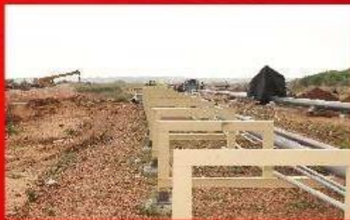
Laying of 20" LNG pipeline
